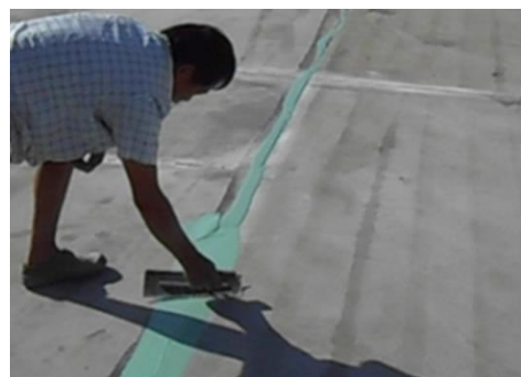
ซ่อมแซมรอยแตกและรอยต่อคอนกรีต ด้วยซีลแลนท์
